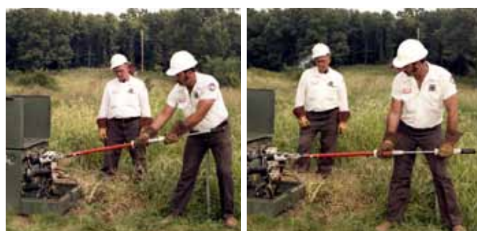
Extractor de Codos tipo Impacto (Las agarraderas no están incluidas y se deben ordenar por separado. Ver la tabla AGARRADERAS DE REEMPLAZO página 2104.)
