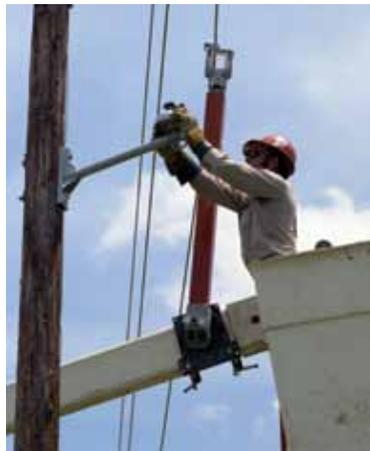
El soporte de conductor para elevación simple puede girarse para alinearlo con el conductor.
