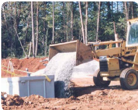
Coloque grava en la caja y a su alrededor. Levante la caja para que la grava se deslice por debajo.
