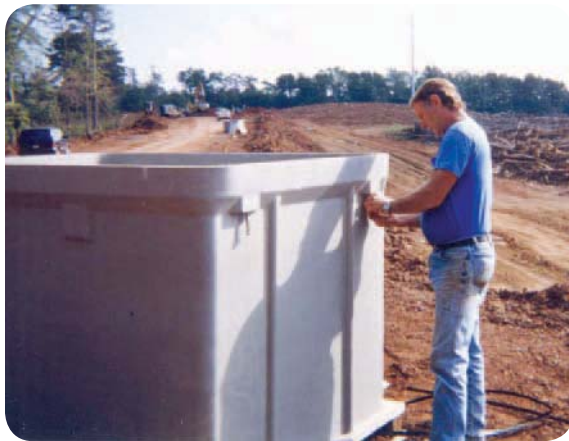
Sujete correas de nylon o cadenas a los pernos de elevación.
