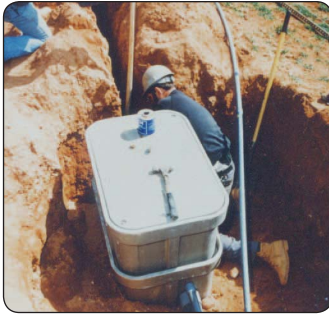
Las cajas QUAZITE® se utilizan en los sistemas subterráneos de fibra óptica y cables eléctricos.
