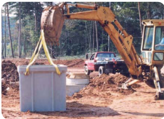
Levante y coloque la caja con la retroexcavadora.
