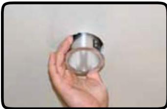
Pincez les ressorts de retenue, insérez le module de lumière dans l'ouverture du plafond et poussez jusqu'à ce que les ressorts se déploient dans le plafond en verrouillant le luminaire en place.
