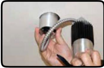
Insérez le tube de raccordement dans l'ouverture du plafond. Le tube de raccordement est conçu pour reposer simplement sur le matériau du plafond. (remarque : ce luminaire est conçu pour être installé dans un plafond non isolé. Voir l'illustration de l'installation ci-dessus.)
