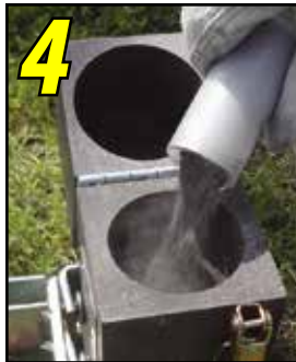
Pour powder into crucible.
