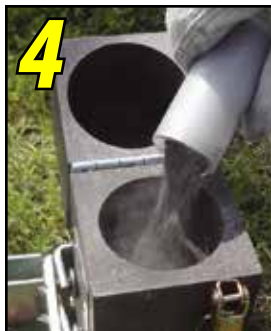
Pour powder into crucible.
