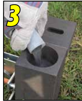
3 Pour powder into crucible.
