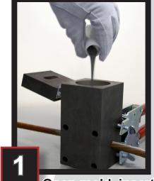
Open mold, insert steel disk and pour in weld metal.
